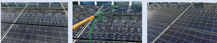
作業前 → 作業中 → 作業後
