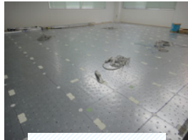
OAフロア化工事中
