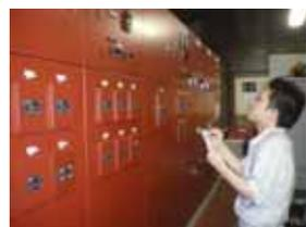
電灯盤の電流を測定
