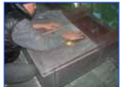
1. 付着物を分解する薬品を塗布し、写真のようにダイヤモンドパットで表面を磨きます。
