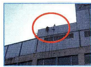
↑準備が完了し、降り始めるところです。作業員によれば、この時が一番緊張するそうです。
