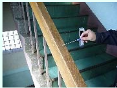
某ビル内 階段手摺
